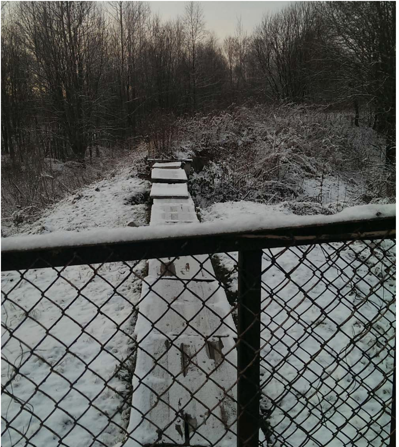
Рисунок 10 - Самотечный железобетонный коллектор Ду 400 переходящий в лоток
