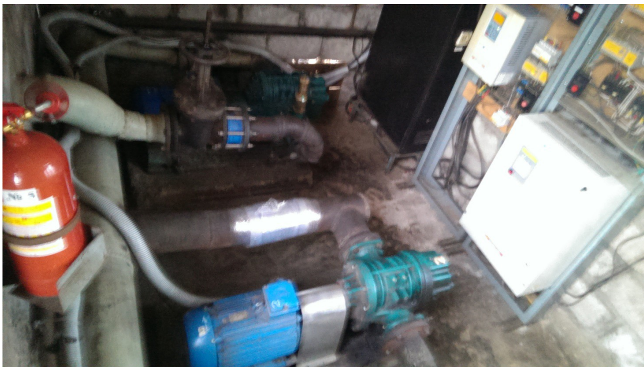
Рисунок 17 - Ротационные воздуховодки аэрационной системы
