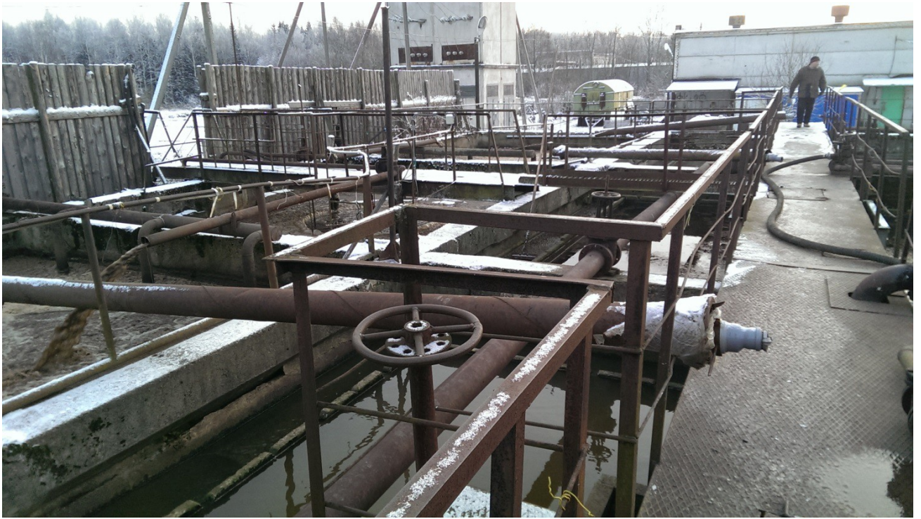
Рисунок 18 - Отстойники и минерализаторы КОС п. Щеглово (справа налево)
