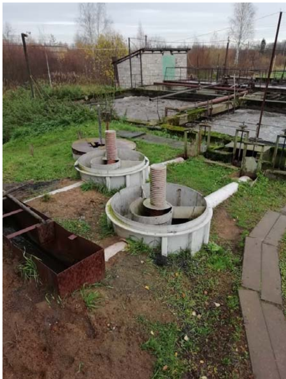
Рисунок 13 - Распределительный лоток
