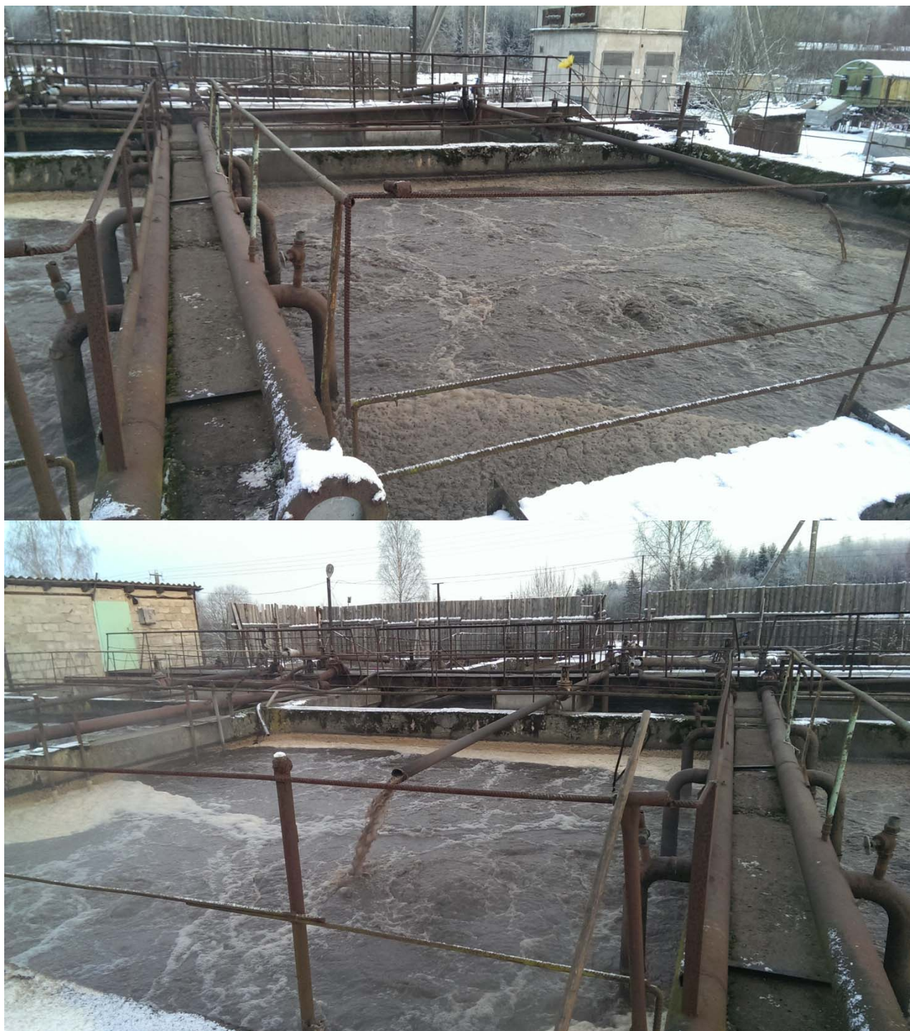
Рисунок 16 - Аэротенки полной биологической очистки КОС п. Щеглово
