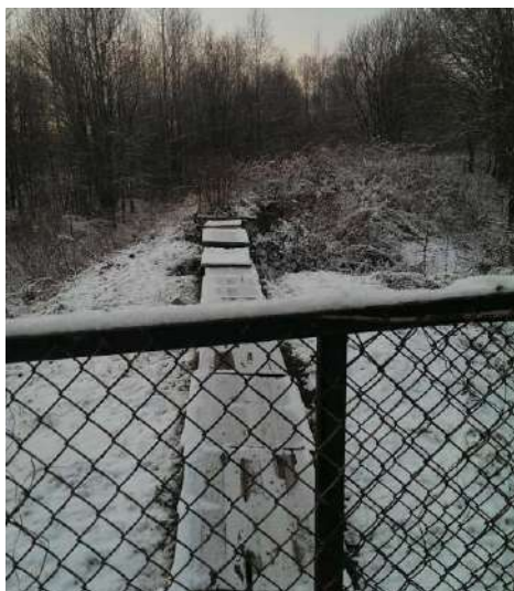
Рисунок 11. Самотечный железобетонный коллектор Ду 400 переходящий в лоток
