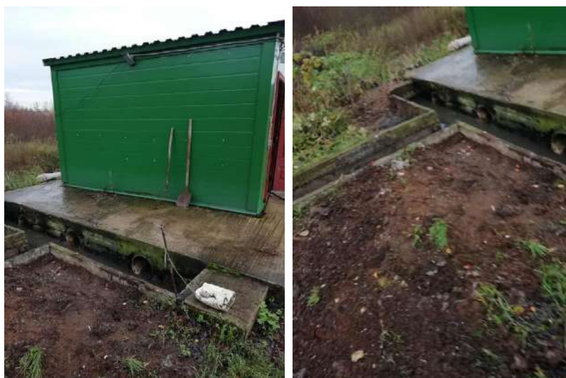
Рисунок 12. Приемный лоток перед зданием решеток
