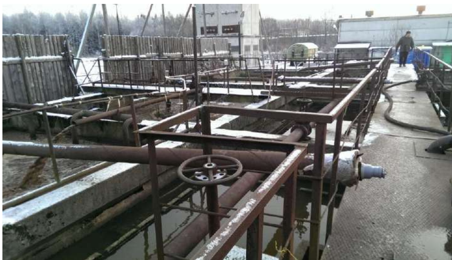
Рисунок 16. Отстойники и минерализаторы КОС пос. Щеглово
