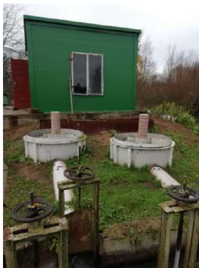
Рисунок 14. Тангенциальные песколовки
