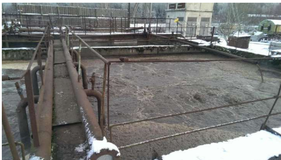
Рисунок 15. Аэротенки биологической очистки КОС пос. Щеглово
